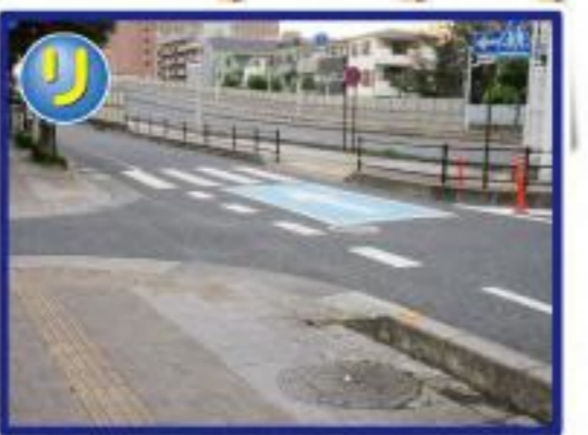
上木崎小北歩道橋下
