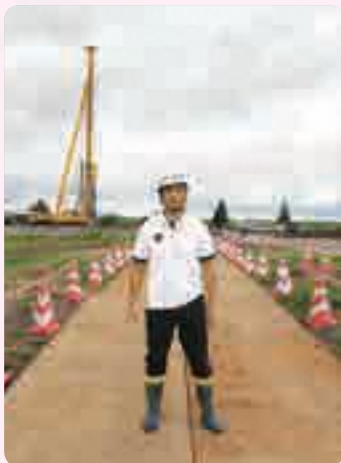
第二調節池建設現場内
