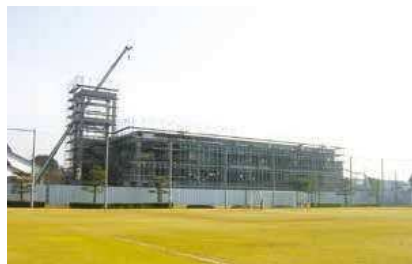
平成14年11月頃、建設途中の現区役所
