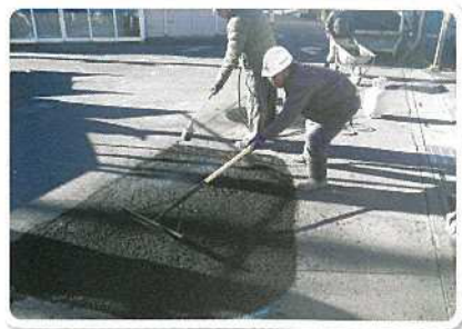
道路の緊急修繕
