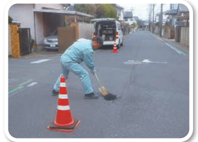
道路緊急修繕
