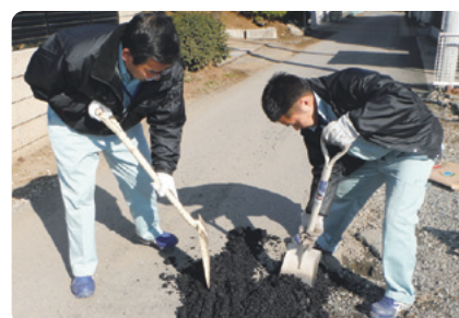
土木緊急修繕
