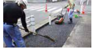
①道路修繕
