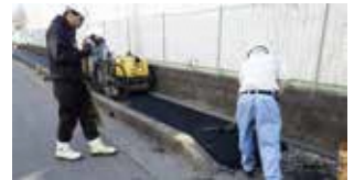
①道路修繕
