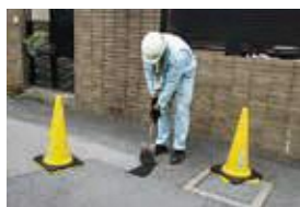
道路緊急修繕
