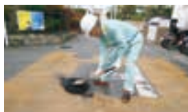
道路緊急修繕
