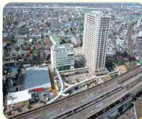
第1街区再開発事業施工状況
