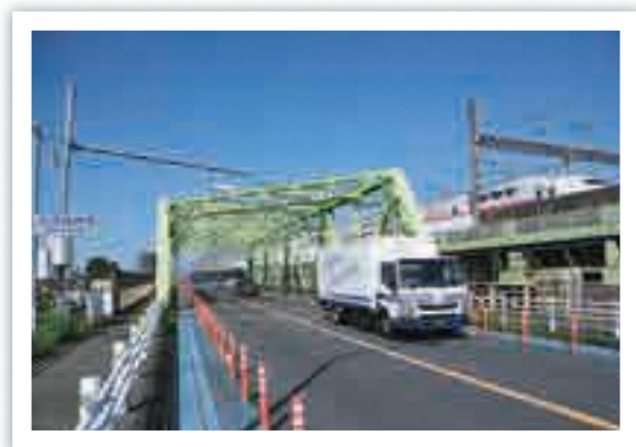
現在の大成跨線橋
