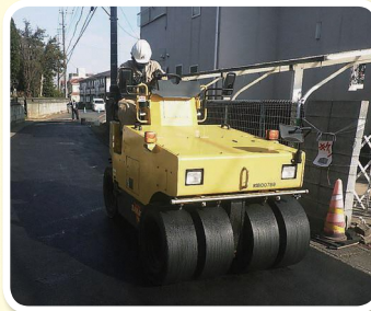
▲道路等の緊急修繕
