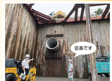
貯留施設(昨年7月時点の写真)
