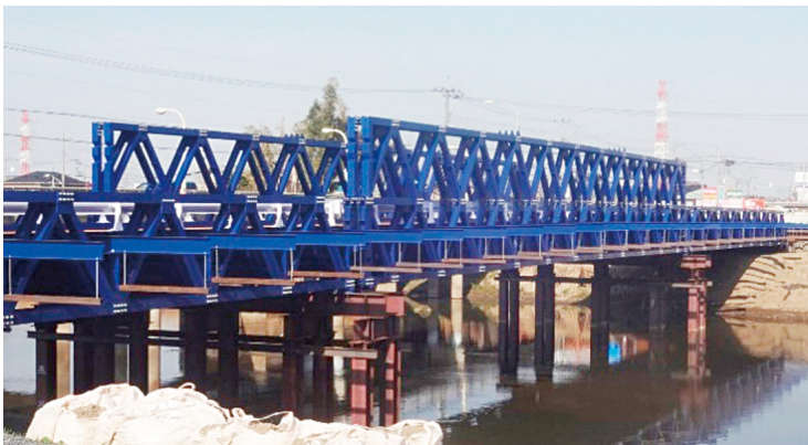
岩槻橋の整備
