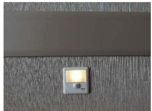
夜間用の足元灯の設置
