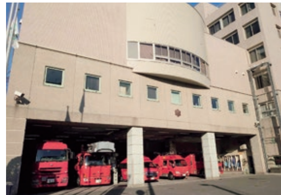
消防署所や消防車両などの整備について 想定のない事象も踏まえた対応が求められる
