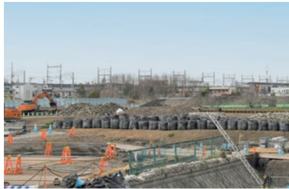
整備工事が進む与野中央公園周辺 周辺住民への丁寧な対応が求められている
