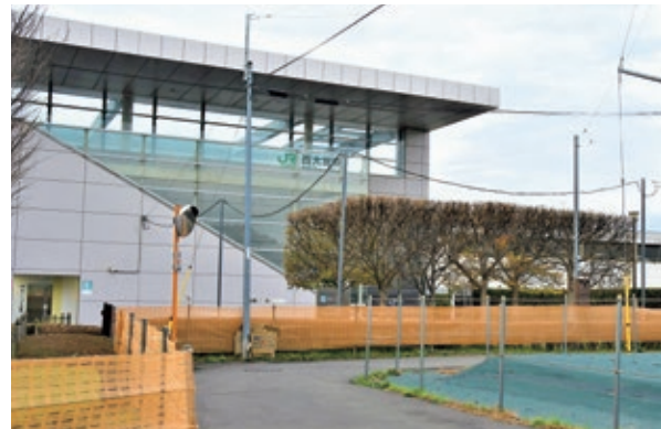
開業以来不便な状況が続く西大宮駅南口 一日も早いロータリーの整備が求められる
