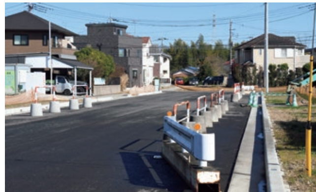
武蔵野線北側で整備中の都市計画道路 開通により利便性の向上が見込まれる
