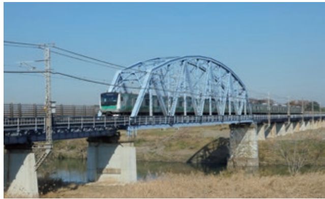
架替えが計画される川越線の荒川橋梁 複線化を望む利用者は多い
