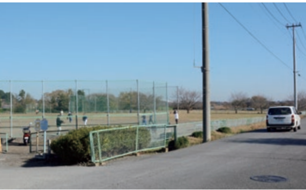
ファウルボールが道路や駐車場に飛び出し危険な状況の見沼臨時グラウンド
