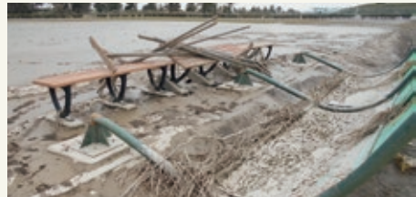
荒川に隣接したグラウンドでも大きな被害が発生
