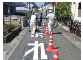
①路面表示修繕の様子
