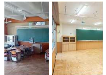
③学校施設リフレッシュ推進事業 上落合小学校 (写真 左：整備前 右：整備後)
