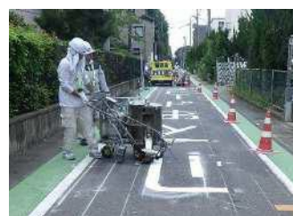
①路面表示修繕の様子
