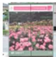
トランスボックス ラッピング
