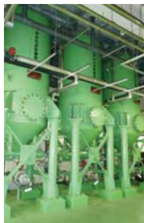
活性炭吸着塔 Activated Carbon Column 残存する色度や臭いの成分などを取り除きます。
