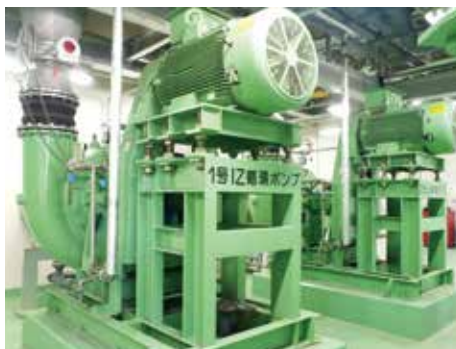
IZ 循環ポンプ IZ Circulating Pump
