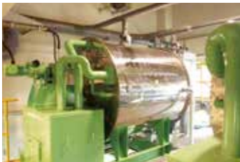
細目ドラムスクリーン Fine Drum Screen
