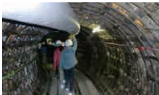
▲貯留管工事の見学会の様子
