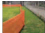
▲設置したネット
