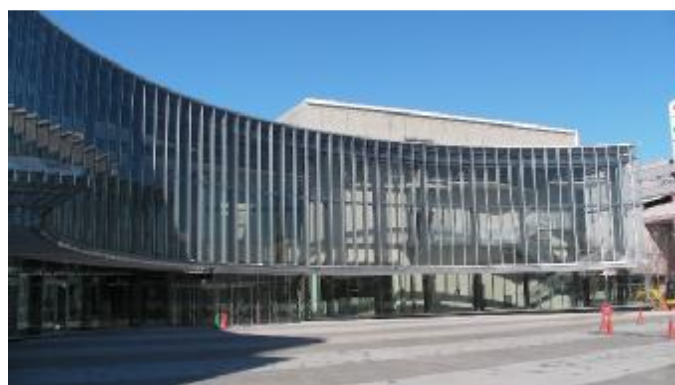
【プラザノース（北区）外観】
