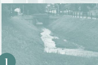
1 実演開始前の東縁一の関。見沼代用水東縁から取り入れられた水は、芝川（写真奥）へ向かって流れていく。
