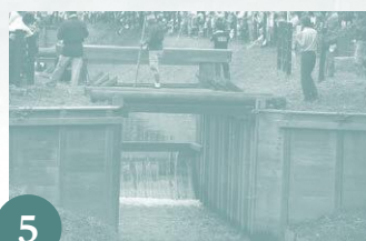
5 一の関に角落を7枚取り付け付けたところ。3の写真と比較すると、水位が上昇していることがわかる（実演開始後、約50分経過）。
