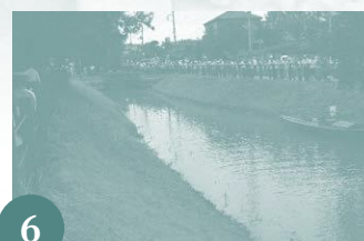
6 一の関と二の関の間の水位が上昇し、二の関を通過できるようになる（実演では船は二の関を通過しません）。
