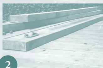
2 角落（かくおとし）と呼ばれるこの板を、関枠に取り付けたり、取り外したりすることによって関の開閉を行う。
