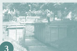
3 一の関に角落を3枚取り付け付けたところ（手前が芝川側）。関枠より上流部分の水位が徐々に上昇していく。
