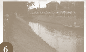
6 一の関と二の関の間の水位が上昇し、二の関を通過できるようになる（実演では船は二の関を通過しません）。
