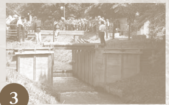
5 一の関と二の関の間の水位が上昇し、二の関を通過できるようになる（実演では船は二の関を通過しません）。
