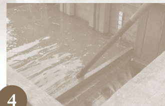
2 一角落（かくおとし）と呼ばれるこの板を、関枠に取り付けたり、取り外したりすることによって閘門の開閉を行う。
