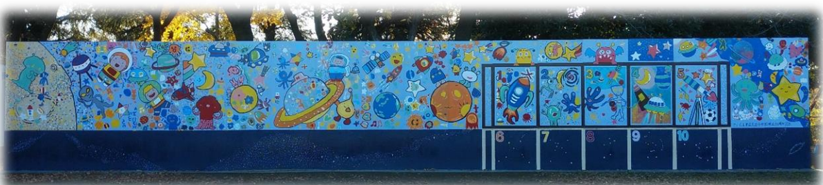
改修されたシュート板
