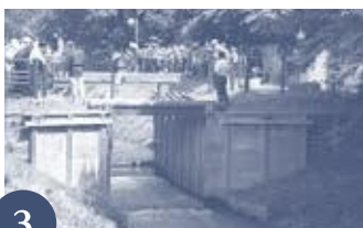
3 一の関に角落板を3枚取り付けたところ(手前が芝川側)。関枠より上流部分の水位が徐々に上昇していく。
