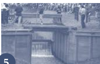
5 一の関に角落板を7枚取り付けたところ。3の写真と比較すると、水位が上昇していることがわかる(実演開始後、約1時間経過)
