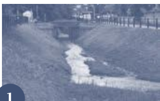
1 実演開始前の東縁一の関。見沼代用水東縁から取り入れられた水は、芝川(写真奥)へ向かって流れていく。
