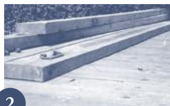
2 角落(かくおとし)と呼ばれるこの板を、関枠に取り付けたり、取り外したりすることによって開閉を行う。
