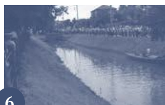
6 開室内(一の関と二の関の間)の水位が上昇し、二の関を通過できるようになる(実演では船は二の関を通過しません)。
