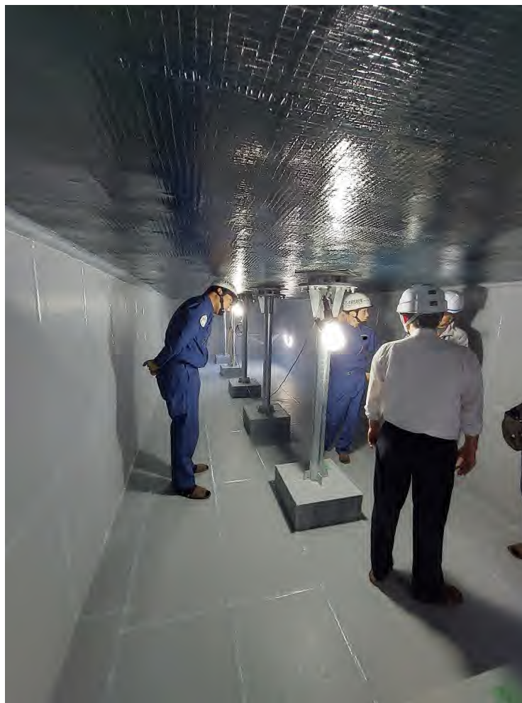
画像：既存防火水槽長寿命工事（R5）
