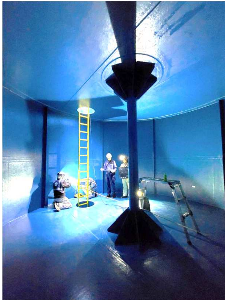
画像：耐震性防火水槽設置工事100m 3 型
