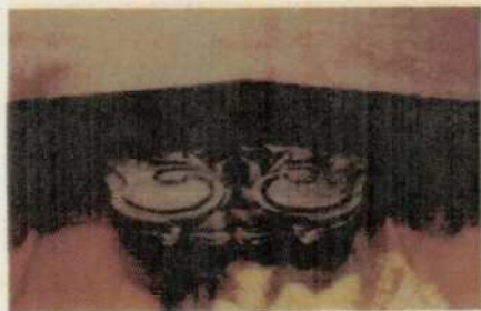
上 応接室窓枠の木鼻状の彫刻
