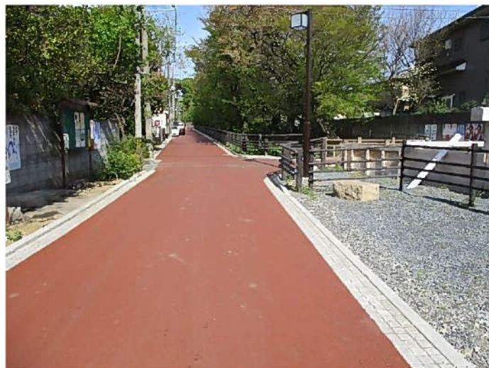
完成した東縁（園路北側）
