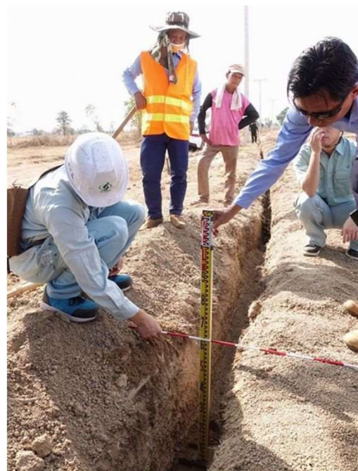
写真 4 水道管布設現場での 支援状況
