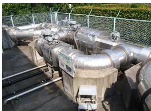
写真 3-6-4 小水力発電設備(白幡配水場)
