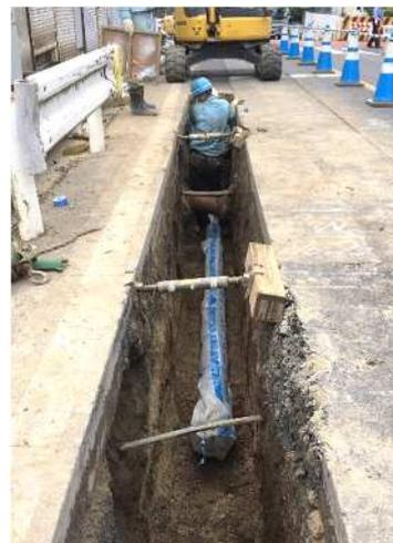
写真 5-2-2 配水管の布設替え
