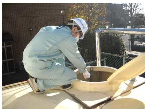
写真 5-1-2 小規模貯水槽水道の訪問点検
