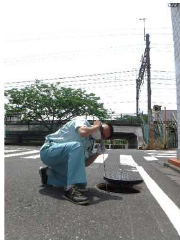
写真 5-2-1 漏水調査
