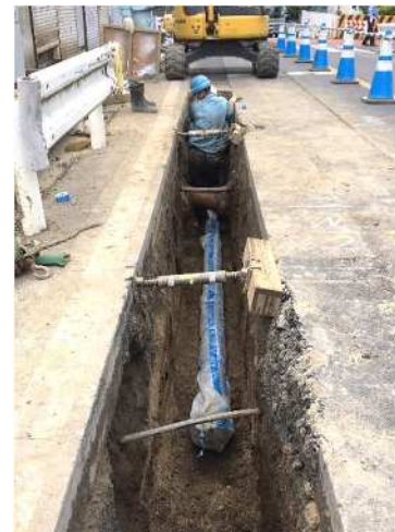
写真 5-2-2 配水管の布設替え
