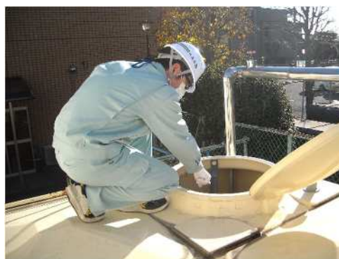
写真 5-1-2 小規模貯水槽水道の訪問点検
