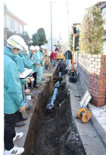
写真 5-2-2 配水管の布設替え
