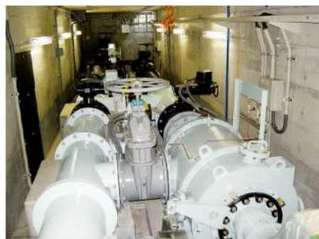
写真 5-5-2 小水力発電設備(大宮配水場)
