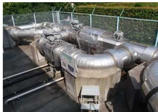
写真 3-6-4 小水力発電設備(白幡配水場)
