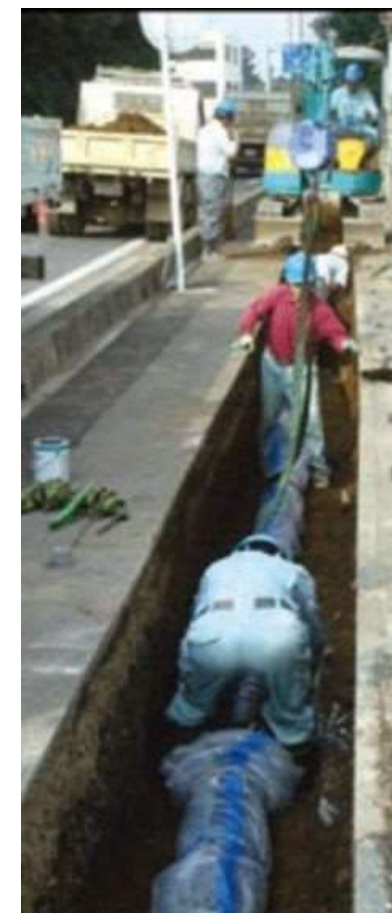
写真 4 配水管の布設替え
