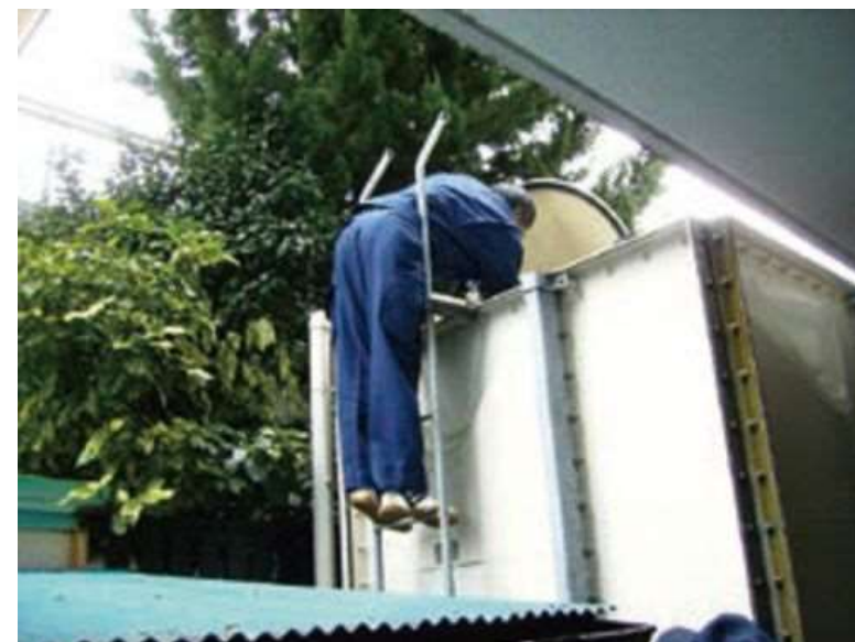
写真 2 小規模貯水槽水道の訪問点検
