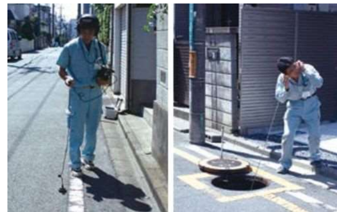
写真3 漏水調査
