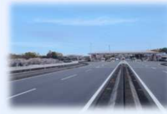
新見沼大橋有料道路（出典：埼玉県道路公社HP）
