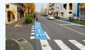
自転車通行環境の整備
