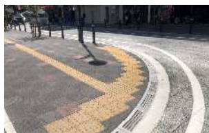
① 幅が広く段差の少ない歩道
