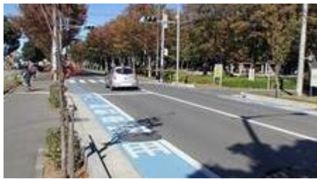
市内における自転車レーンの整備事例（左：自転車専用通行帯 右：矢羽根型路面標示）
