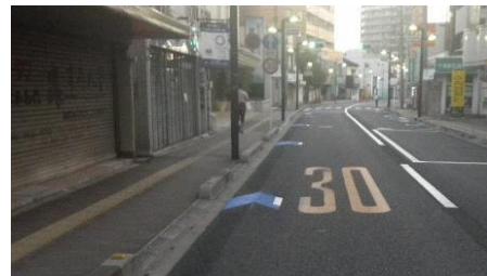
市内における自転車レーンの整備事例（左：自転車専用通行帯 右：矢羽根型路面標示）
