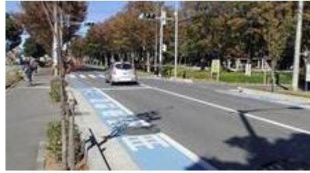
市内における自転車レーンの整備事例（左：矢羽根型路面標示 右：自転車専用通行帯）
