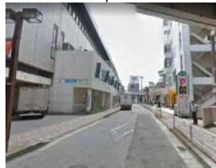
④ デッキのない区間
