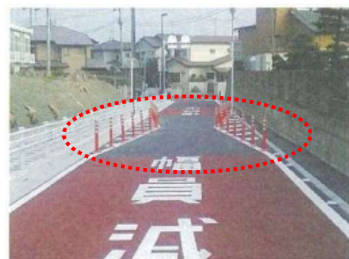
図 実験②：狭さくの設置*2
