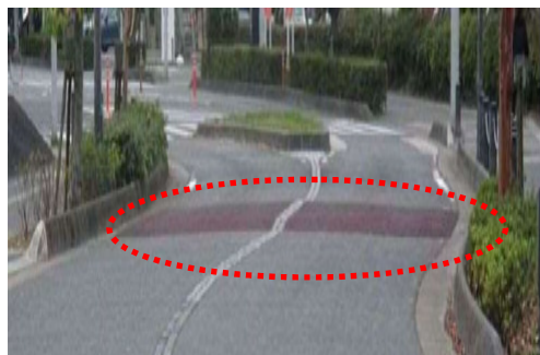
図 実験④：ハンプの設置*3
