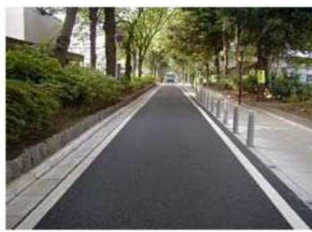
工事後：歩行者空間と車道が分離された参道
