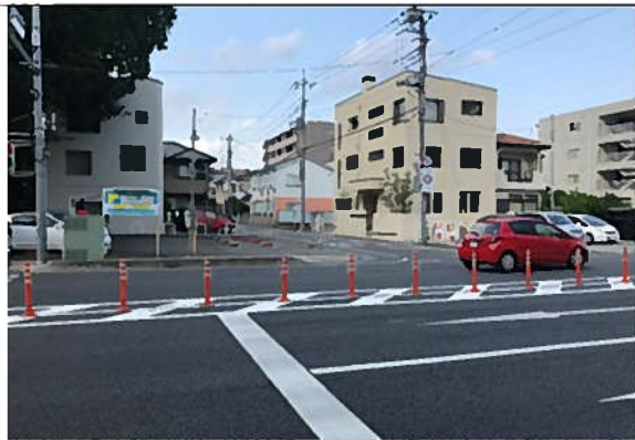
右折抑制用ポール設置
