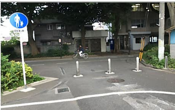
車止め（側道交差部）
